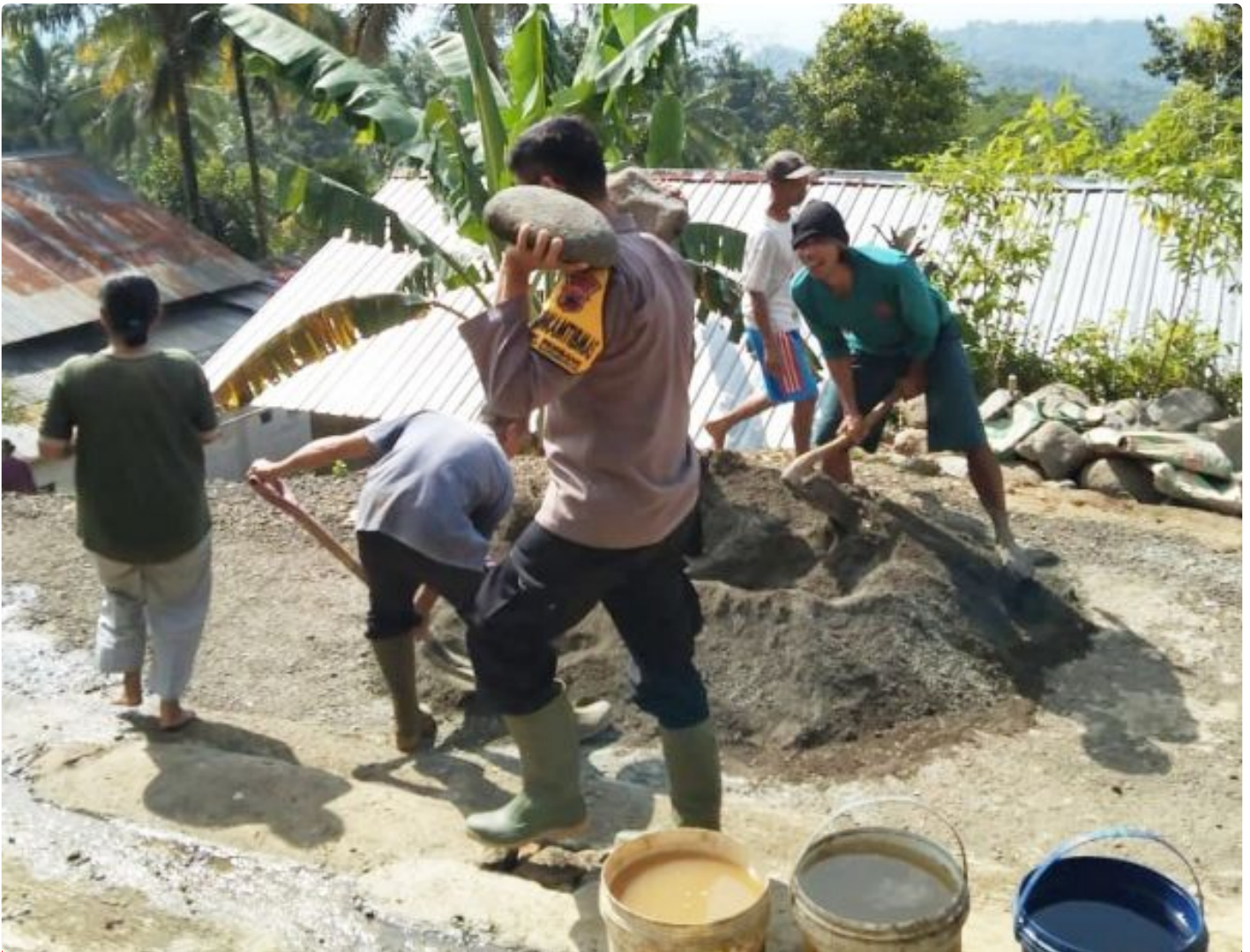
Bhabinkamtibmas Polsek Rembang Bersama Warga Kerja Bakti Perbaiki Talud Longsor
